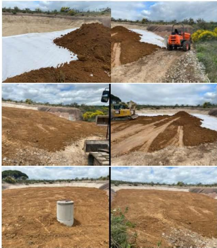
FIGURE 1 : PHOTOGRAPHIES DE L'OPERATION DE RECOUVREMENT DE L'ALVEOLE BIG BAGS
